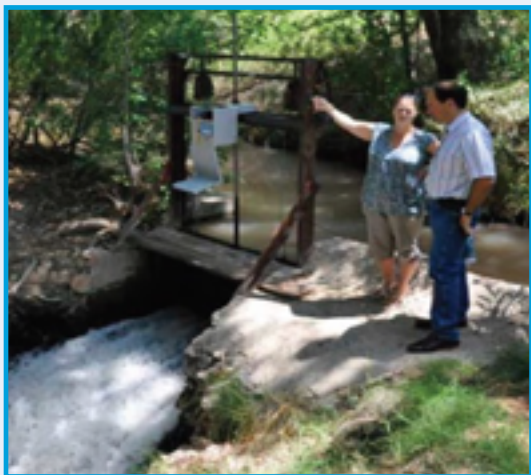
弗德河上的灌溉基础设施
