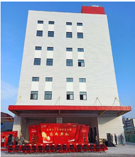
浙江太古可口可乐下沙厂生产车间扩建工程 1 号楼
