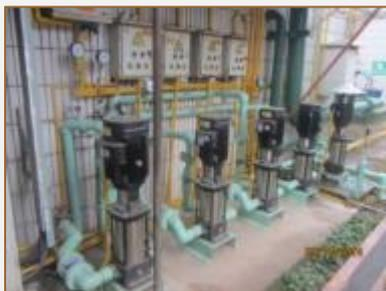
◆2013年年中，I、II、III、V期机库屋面中水备用加压泵备用泵安装完成，可以解决在主用泵故障时，仍保证中水的正常供应。
