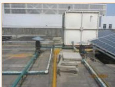
◆为方便辨识管理，将电镀废水系统、生产废水系统、中水系统分别粉刷不同颜色的漆进行区别。
